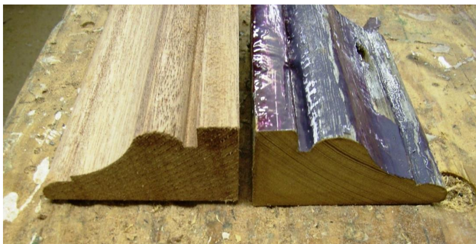
Gekopieerd lijstprofiel. Het origineel is niet ontverfd voor het kopiëren, wat afwijkingen kan veroorzaken in de maatvoering. Ook is een niet-geëigende houtsoort gebruikt (meranti).
