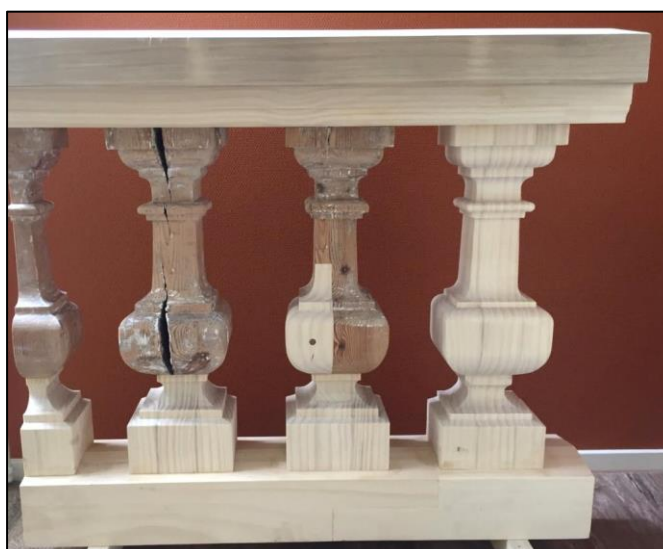
Proefopstelling van een gerepareerde balustrade. De bestaande houtsoort grenen is gecombineerd met samengestelde deelvervangingen in Accoya®.
